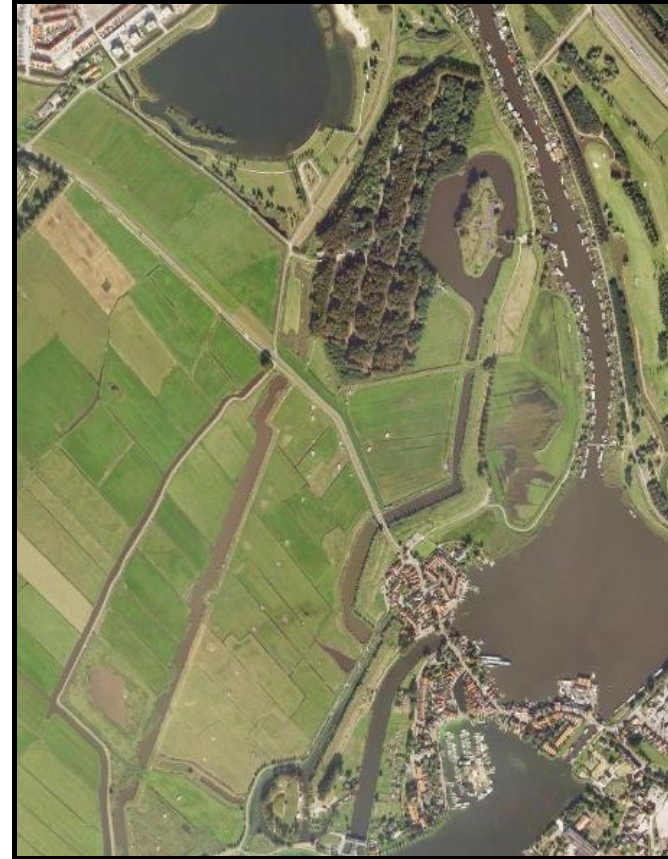
Luchtfoto van de Positie bij Spaarndam met rechts boven Fort benoorden Spaarndam. Tegenover het fort ligt het bos met het munitiedepot. Midden onder: Fort bezuiden Spaarndam.
